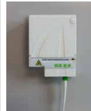
Point de raccordement du fibre optique
